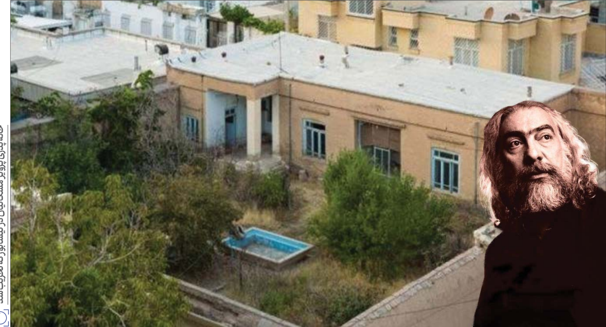
خانه پدری پرویز مشکاتیان در نیشابور که تخریب شد
